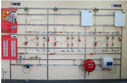
Рис. 1 Гідралічний стенд в лабораторії «Енергоефективні системи забезпечення мікроклімату будівель» компанії «HERZ Armaturen» (ауд. 652)
