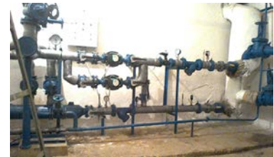
Рис. 3 Автоматизований вузол регулювання теплової енергії навчального корпусу №6
