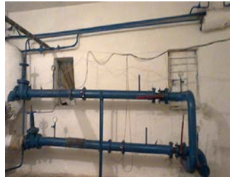
Рис. 2 Витратомірні ділянки і датчики температури лічильника тепла навчальних корпусів
